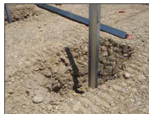
Figure 4 : Types de fondation - pieux battus (Source : Guide MEDDTL 2011 – NCA, 2015)
