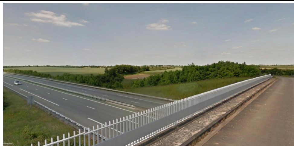
Photographie de l'état initial
