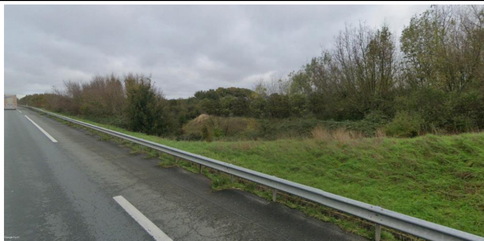
Photographie de l'état initial
