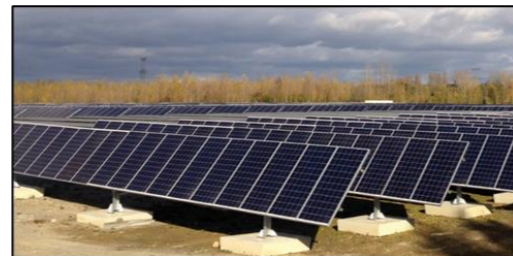
Figure 5 : Types de fondation - semelle béton (Source : URBASOLAR)
